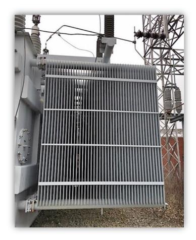
Les revêtements de Galvatech sont utilisés pour galvaniser les radiateurs et les équipements de sous-stations
