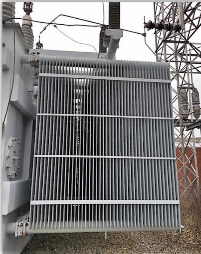
Les revêtements de Galvatech sont utilisés pour galvaniser les radiateurs et les équipements de sous-stations
