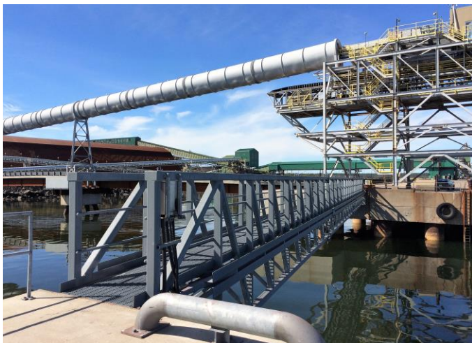
Passerelle port de Sept-Îles
