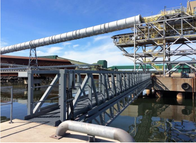
Port of Sept-Îles footbridge
