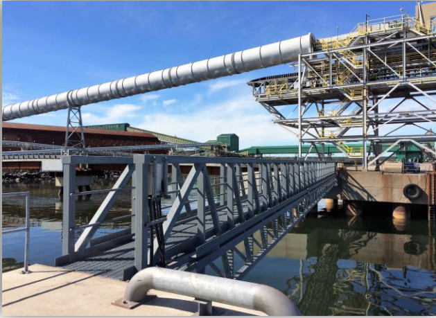
Port of Sept-Îles footbridge
