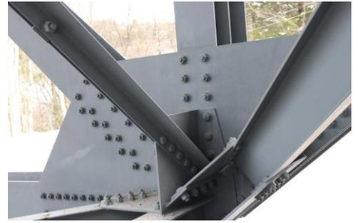
Pont de 100 000 pi<sup>2</sup> d'acier, qui a été construit avec des poutres galvanisées à chaud il y a environs 50 ans et rechargé en zinc à l'aide du Rust-Anode Primer.
