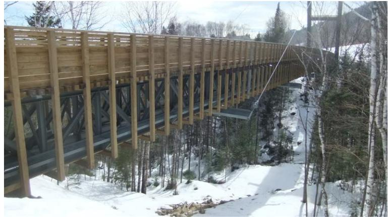
Cette construction neuve de pont suspendu et totalement galvanisé avec notre technologie a été installé en 2016 dans le bas des pentes du centre de ski Le Massif de Charlevoix.
