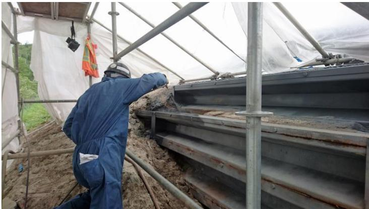
Réfection d'un mur de soutènement de la route Transcanadienne effectuée en 2017. Galvanisé grâce à notre technologie, ce mur est en contact avec des sols corrosifs et du béton.
