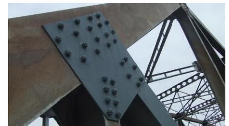
Situé dans la région de Sherbrooke, le sous tablier de ce pont anciennement galvanisé à chaud a été remis à neuf avec le Rust-Anode Primer.
