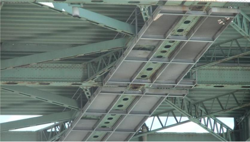
Plateforme sous les joints d'expansion remis à neuf à l'aide du Rust-Anode Primer.
